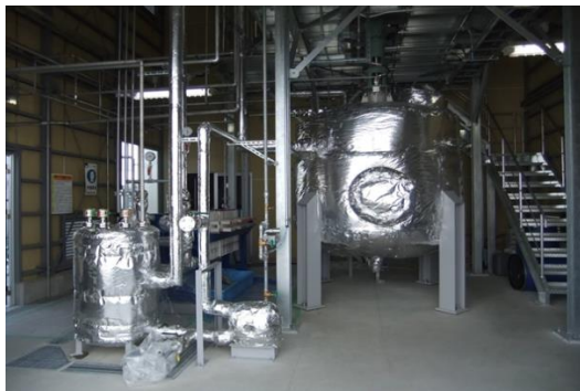
独自開発した廃アルミを原料とする水素製造装置
