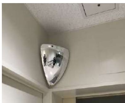
曲がり角にミラーを設置
